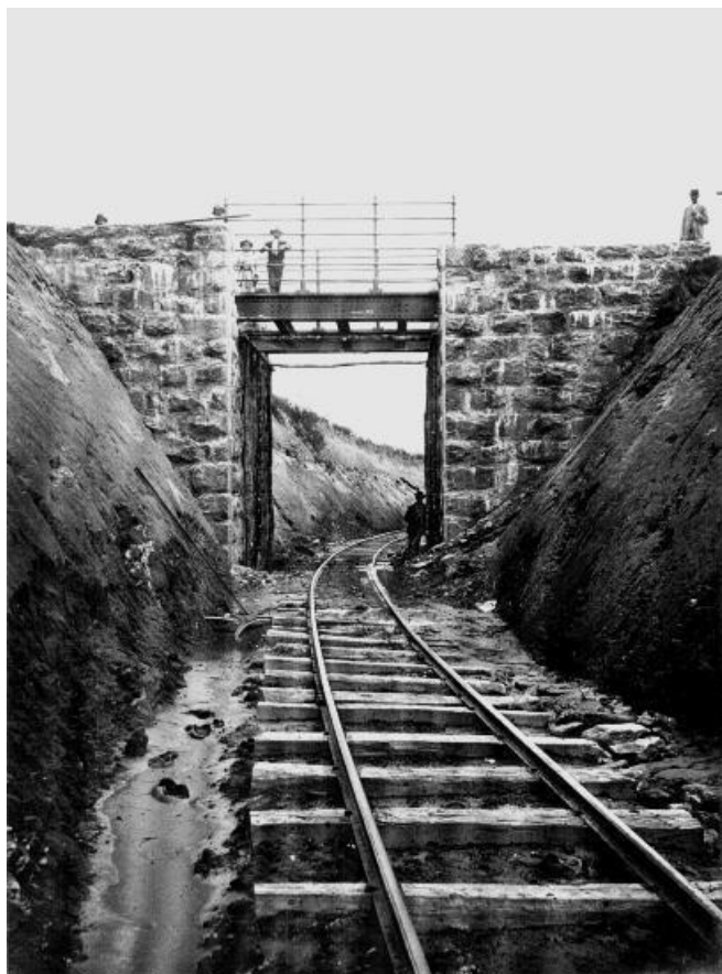
Figura 3: Construção da ferrovia. Primeiro pontilhão em Muzambinho (década de 1910)
