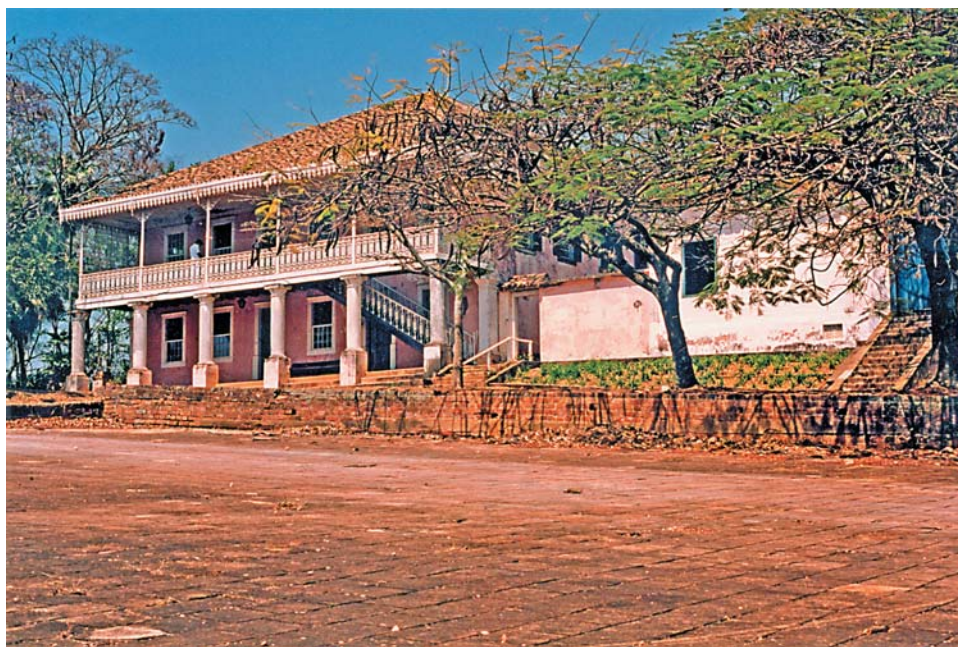
Figura 28 – Fazenda Sete Quedas. Residência da segunda metade do século XIX, assobradada, implantada a meia encosta, edificada em taipa de pilão e taipa de mão, organizada dentro de uma planta em L. Com a construção do alpendre em ferro, datada de 1905, alterou-se o acesso original. Fotografia da equipe.
