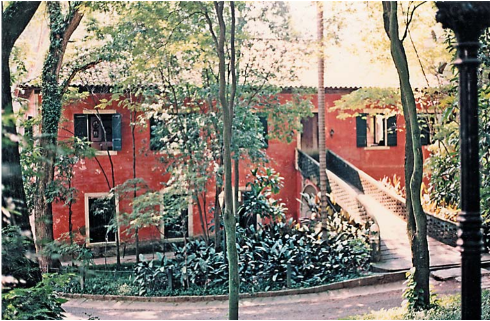
Figura 18 – Fazenda São Martinho. Tulha antiga. Sobrado construído em taipa de pilão, no pavimento térreo e taipa de mão no piso superior. Fotografia da equipe.
