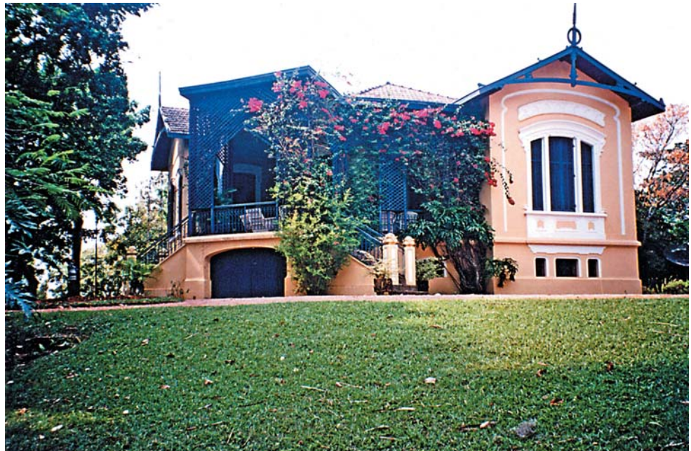
Figura 25 – Fazenda São Vicente. Residência térrea (início do século XX) com características arquitetônicas urbanas. Implantada sobre um platô artificial, foi construída em alvenaria de tijolos. Fotografia da equipe.
