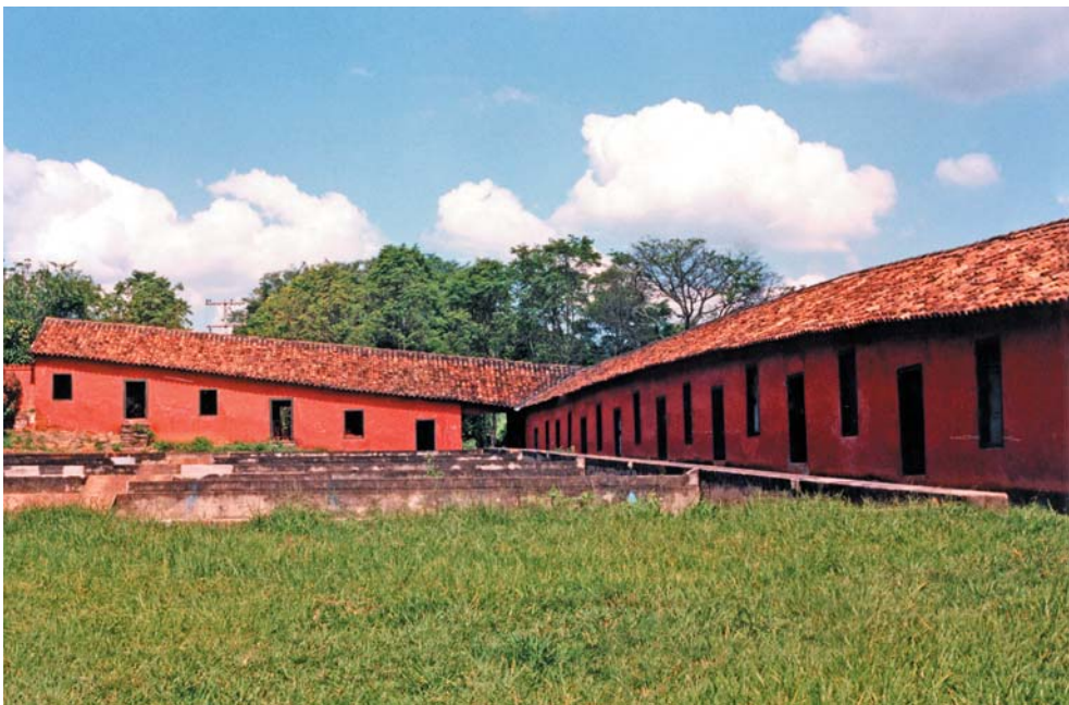
Figura 30 – Fazenda São Martinho. Do antigo curro da senzala (erguida na primeira metade do século XIX) conservam-se duas alas erguidas em paredes de taipa de pilão, sem divisórias internas.
