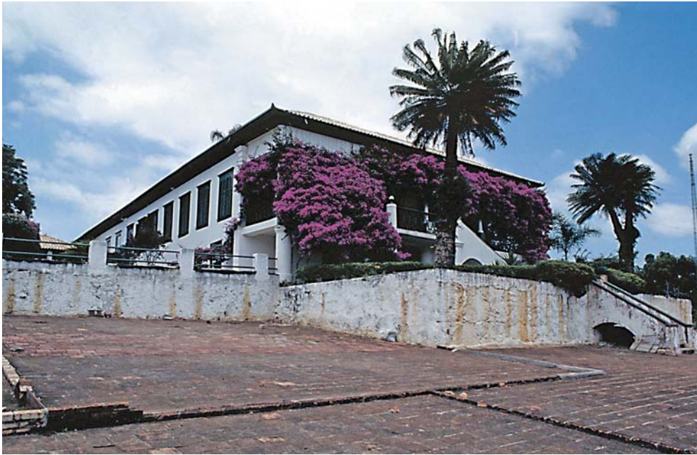
Figura 23 – Fazenda São Pedro. Residência assobradada, que ostenta na ferragem da porta principal a data 1872. Foi implantada em meia encosta, com planta em L. Construída em técnica mista: taipa de pilão (embasamento e paredes externas do pavimento térreo) e taipa de mão e tijolos (demais paredes). Fotografia da equipe.
