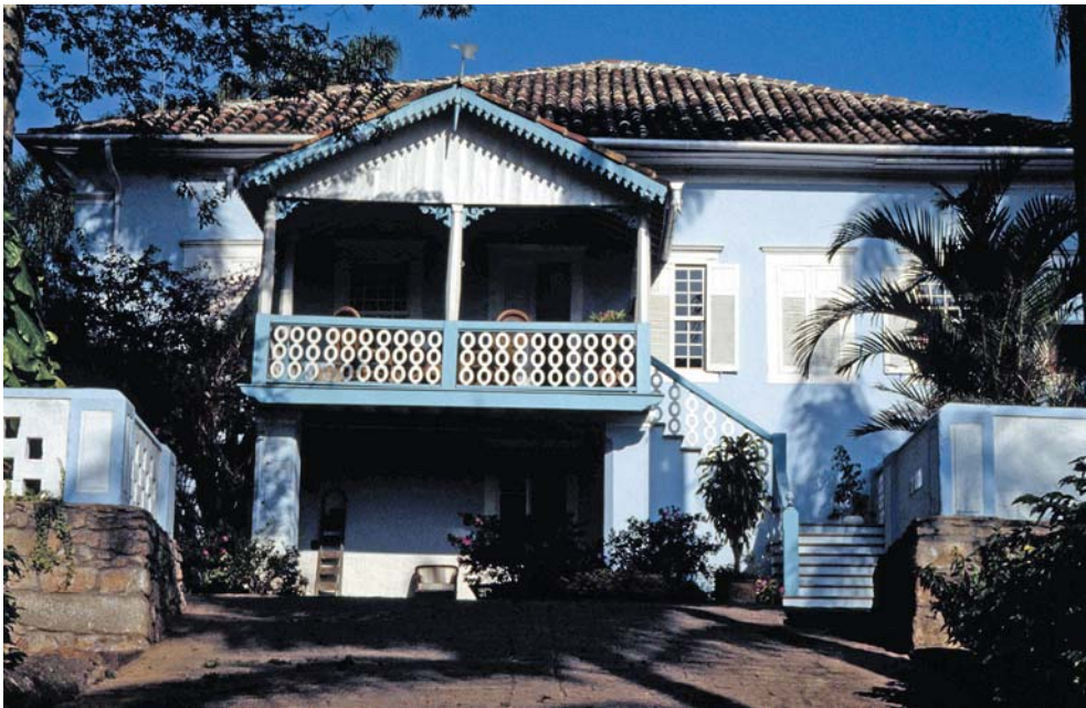
Figura 24 – Fazenda Bonfim. A residência assobradada acha-se a cavaleiro no terreno e implantada a meia encosta, definindo o esquema básico da planta em L. O terraço fronteiro é acréscimo posterior. Fotografia da equipe.
