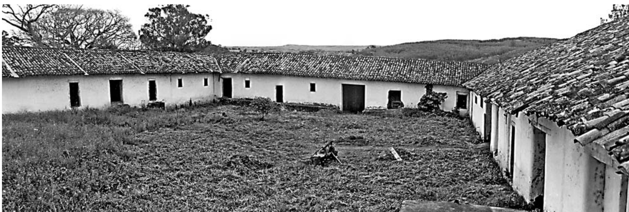
Figura 3 – Fazenda Fazendinha. Grande quadrilátero com pátio central da época do engenho, erguido em taipa de pilão e taipa de mão, sobre embasamento de pedra. A senzala ficava na ala de menor pé-direito, as fornalhas no amplo espaço oposto à porta de entrada e o tendal na parte soalhada à esquerda. Esta última foi transformada posteriormente em tulha para café. Fotografia da equipe.
