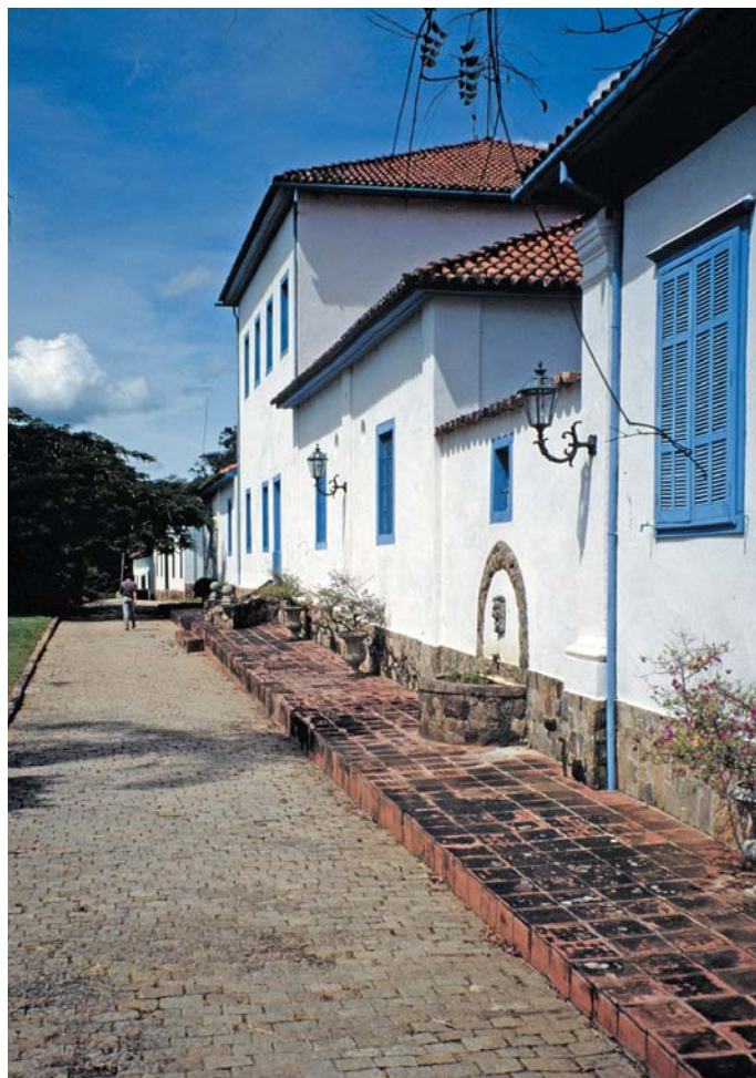
Figura 7 – Engenho Mato Dentro (Jaguari). Depósito e sobrado (primeiro quartel do século XIX), dispostos linearmente na declividade do terreno, erguidos em taipa de pilão. Para Mello Pupo, o depósito seria a primeira residência de Alexandre Barbosa de Almeida (antigo sesmeiro). Fotografia da equipe.
