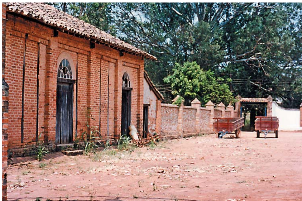
Figura 22 – Fazenda São Vicente. Casa de máquinas e tulha, erguidas entre o final do século XIX e início do XX. Edifício erguido em alvenarias de tijolos aparentes, sobre porão alto necessário à instalação de equipamento de benefício do café. Espaço interno único, com divisórias de madeira. Fotografia da equipe.
